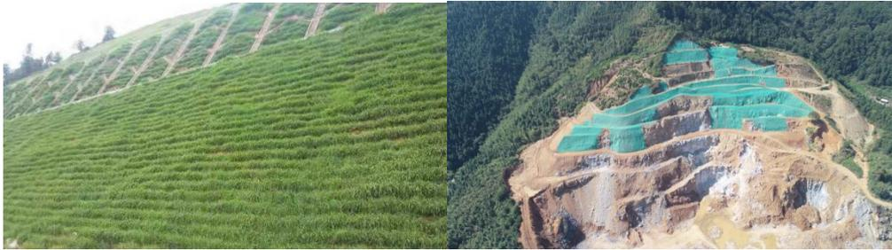
福建金牛水泥矿山采用从上到下阶梯式开采方式，自矿山建设以来就按照国家级绿色矿山标准实施，建设机械化水平高、自动化控制先进，淘汰落后设备，更新新型干湿捕尘凿岩机；配备洒水车，对矿区产尘点及矿山道路进行洒水降尘；在各矿山入口处设有过车池、洗车台；矿山拦截坝下侧、矿山出口处均设有三级沉淀池；排土场设有截、排水沟。
